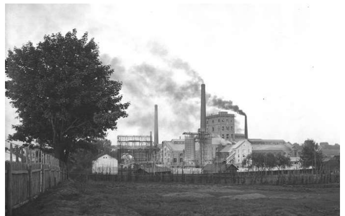
Krakowskie Zakłady Sodowe Solvay.
